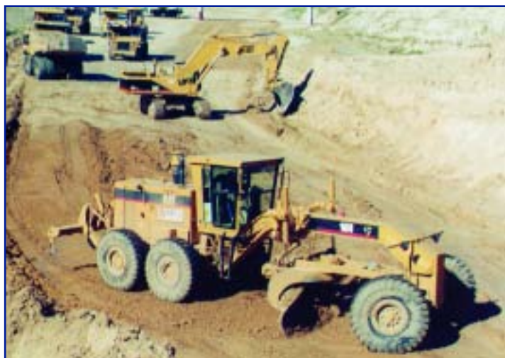
La acumulación de tierras en la zona del Instituto dio origen a una montaña artificial que aglutinó la idea del proyecto.
