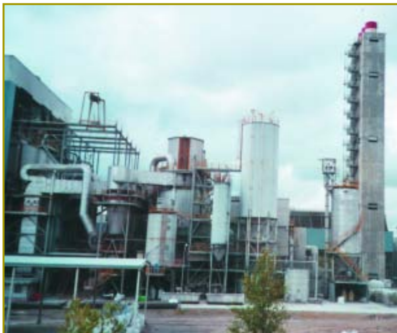
Planta incineradora situada en el Centro “Las Lomas” en Valdemingómez, en Madrid, limitando con el municipio de Rivas Vaciamadrid.
