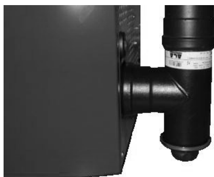
Fig. 43 - Limpieza canal de humos
