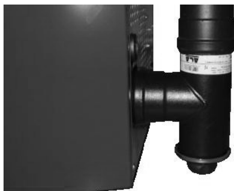
Fig. 82 - Limpieza canal de humos
