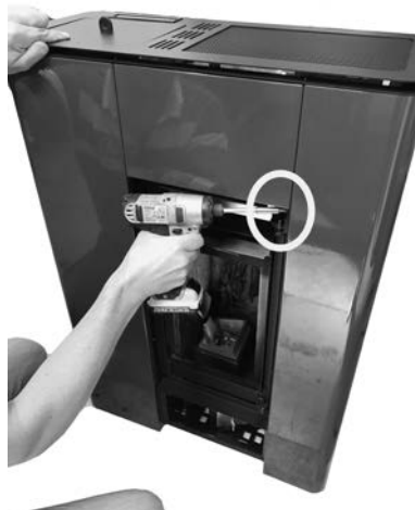
Fig. 41 - Extracción de los tornillos 1
