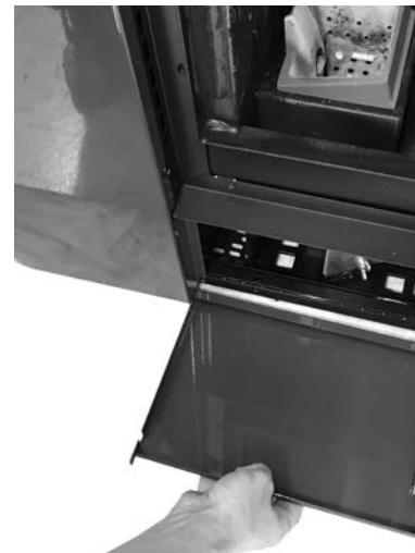
Fig. 42 - Desmontaje de las placas frontales delanteras
