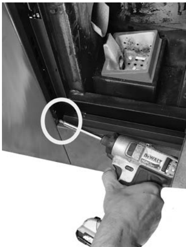
Fig. 40 - Extracción de los tornillos 1
