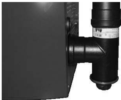
Fig. 59 - Limpieza canal de humos
