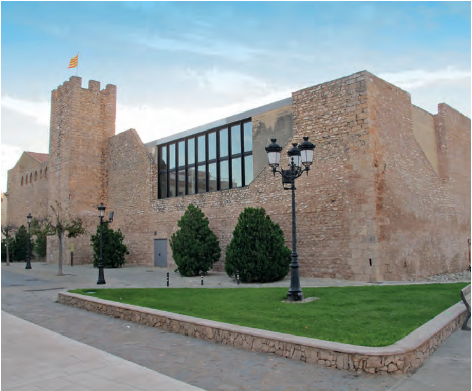
Imatge de l'estat que presenta el sector septentrional de l'antic hospital que queda presidit per la torre nord.
